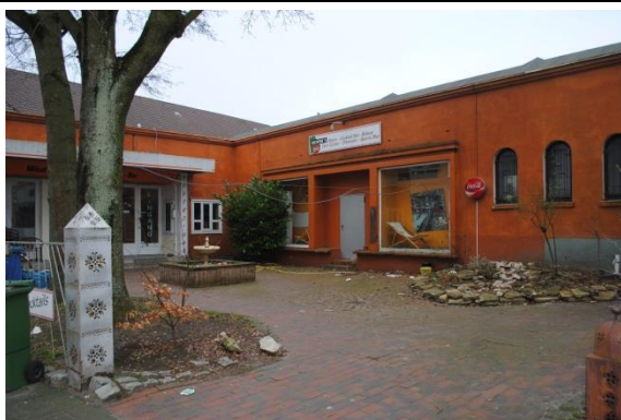
gestalterische Mängel im privaten Außenraum
