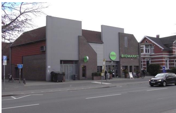
Verbrauchermarkt an der Nadorster Straße
