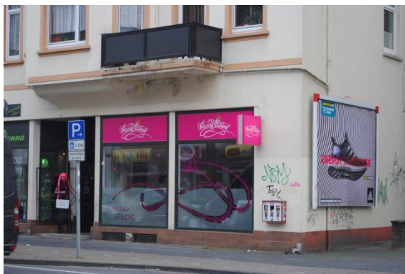
bauliche Mängel/massive Werbeanlagen
