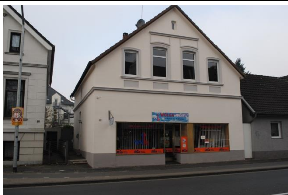
Überformung der Fassadengliederung eines ursprünglich ortsbildprägenden Gebäudes
