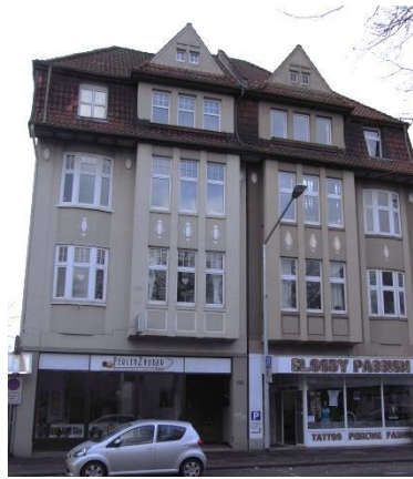
Wohn- und Geschäftshaus Nadorster Straße 105/105A
