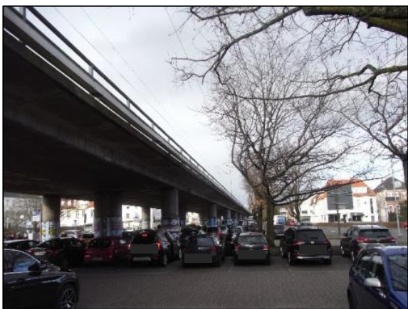
Parkplätze 91er Straße unter der Bahnbrücke
