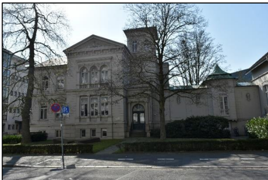
Francksen-Villa (Raiffeisenstraße 31) Fotos: re.urban
