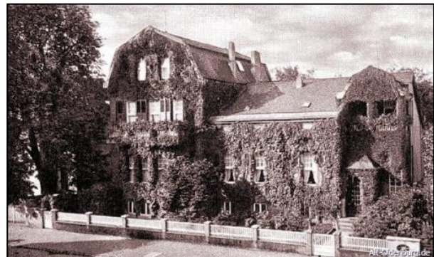
1920 - 1910 ließ der Oldenburger Bankier Ballin das Haus aufwendig umbauen und erweitern. Der Eingang (rechts) und der dreigeschossige Trakt (links) wurden angebaut
