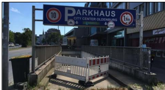
Tiefgaragenzufahrt CCO (Am Stadtmuseum) Quelle: NWZ vom 10.08.2020
