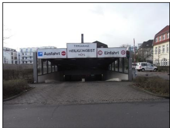
Tiefgarage Heiligengeisthöfe (91er Straße)
