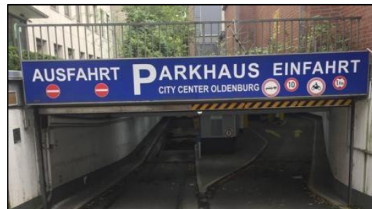
Tiefgaragenzufahrt CCO (Raiffeisenstraße) Quelle: NWZ vom 10.01.2020
