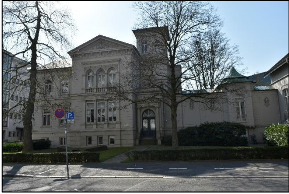
Francksen-Villa (Raiffeisenstraße 33) Fotos: re.urban
