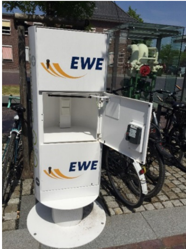
Abbildung 33: Schließfachanlage mit integrierter Lademöglichkeit der EWE
